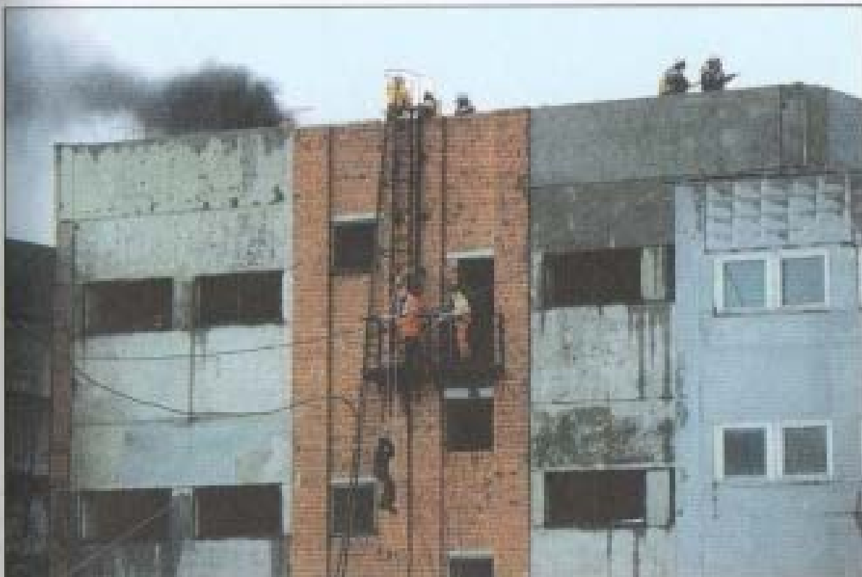
Использование наружных стационарных пожарных лестниц при ликвидации последствий пожара и для эвакуации людей
