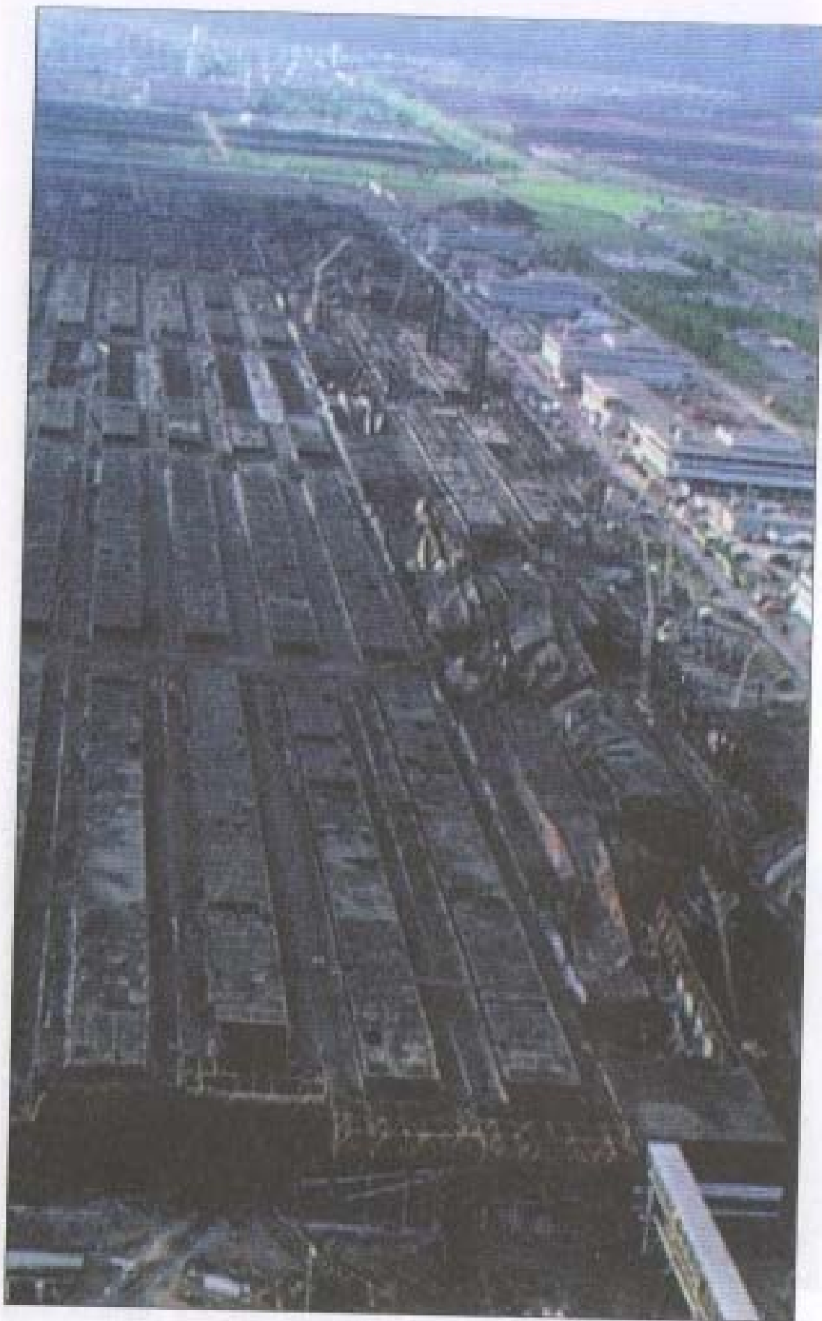
Последствия пожара на заводе двигателей АО «КамАЗ»
