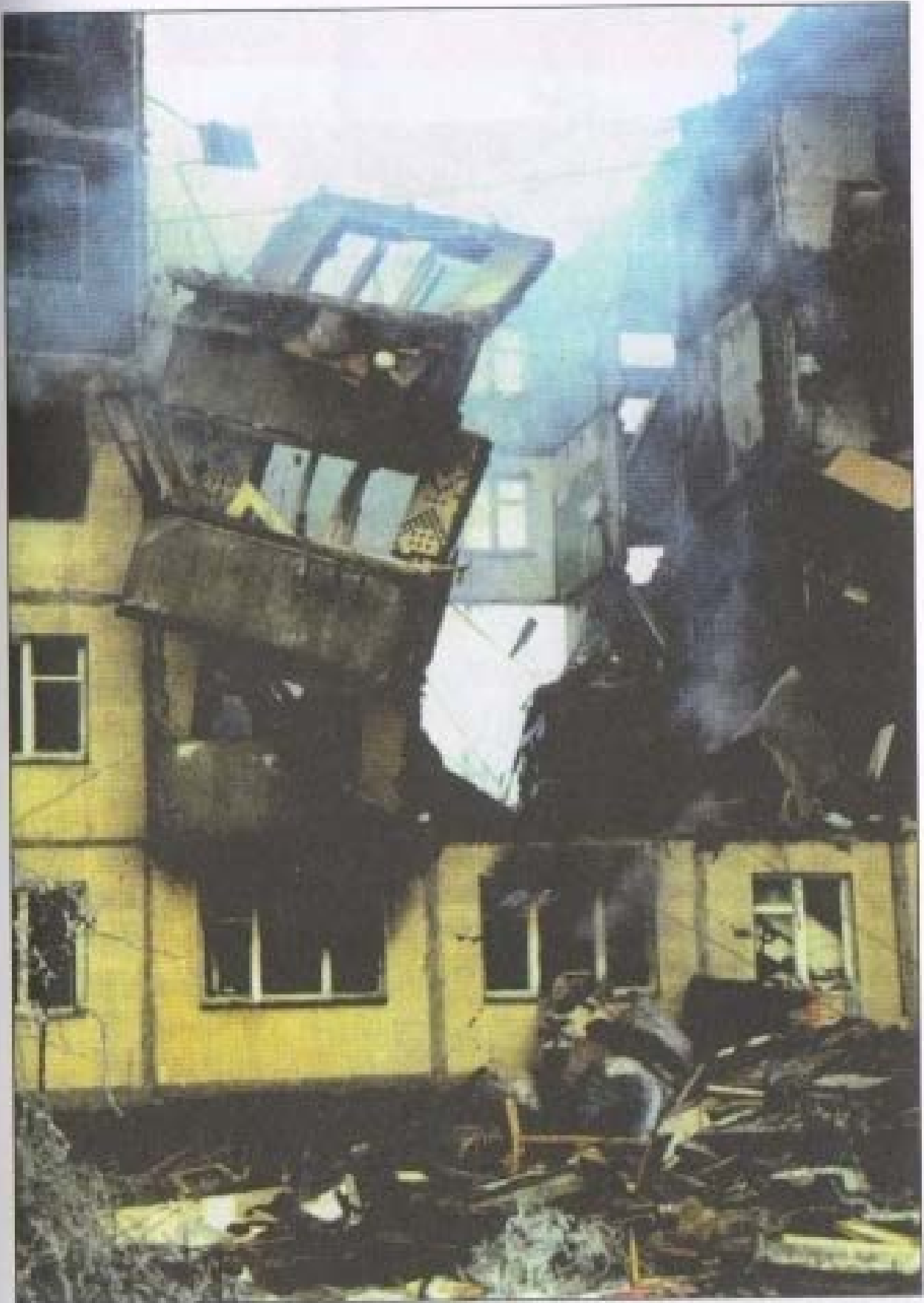
Последствия взрыва газа в жилом доме
